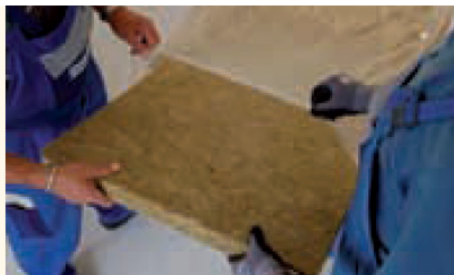
Wsuwanie wkładu akustycznego.
