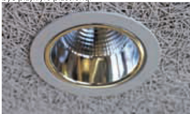
Krawędzie cięcia należy pomalować, jeśli nie mają być przykryte przestoną.
