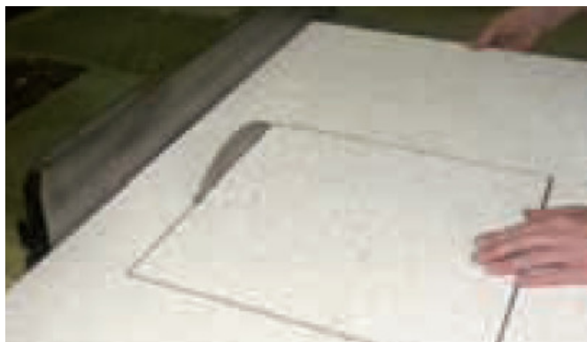
Wycinanie otworu / włazu od strony grzbietowej płyty.
