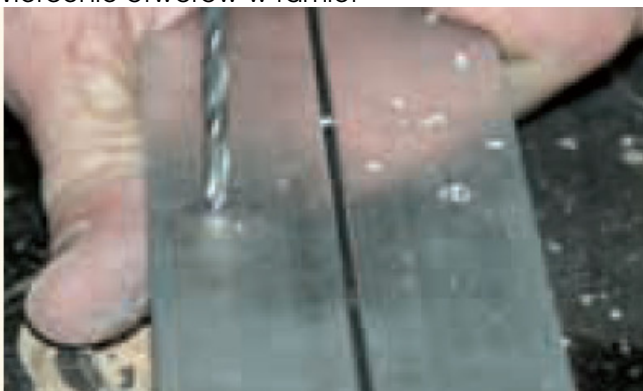
Przykręcanie płyty przykrywającej co najmniej 2 x 4 śrubami 4,5 x 20 mm na każdą ramę 40 x 40 wzgl. 2 x 6 śrub w przypadku ramy 60 x 40 cm i Heraklith-BM PU i klej polimerowy po wewnętrznej stronie ramy.
