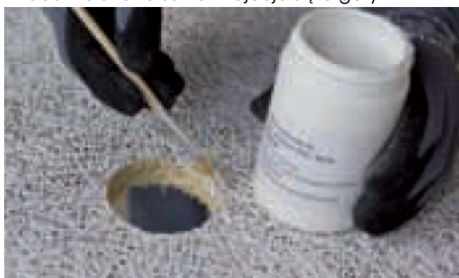
Krawędzie cięcia należy pomalować, jeśli nie mają być przykryte przestoną.
