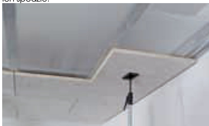
Rozwiązanie alternatywne: układanie folii PE jako ochrony przed pruszeniem materiału lub jako paroizolacji, równocześnie z montażem płyt akustycznych Heradesign. Styki płyt skleić ze sobą.
