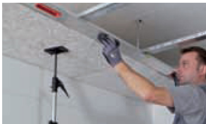
Regulacja ustawienia płyt w jednej płaszczyźnie za pomocą łąty montażowej ( poziomicy ). Styki płyt muszą być umieszczone na środku pod profilem. Niedozwolone jest tworzenie swobodnych styków płyt. Podczas układania płyt kwadratowych należy przestrzegać kierunku układania zaznaczonego na ich spodzie.
