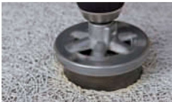
Wiercenie okrągłego otworu na spotlight. Widoczna strona sufitu znajduje się u góry.
