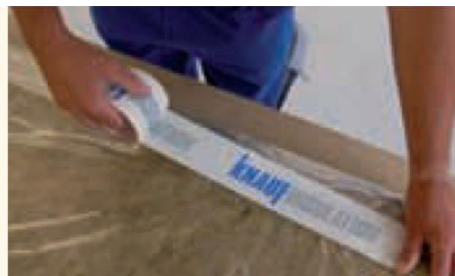
Zaklejenie końców worka
